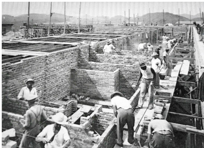
Figura 14 – Execução da alvenaria.
