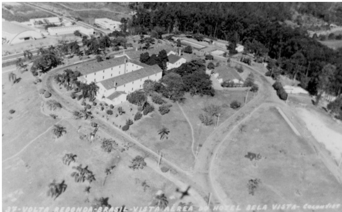
Figura 24 - Foto da década de 1950, sem a ampliação do terceiro bloco.
