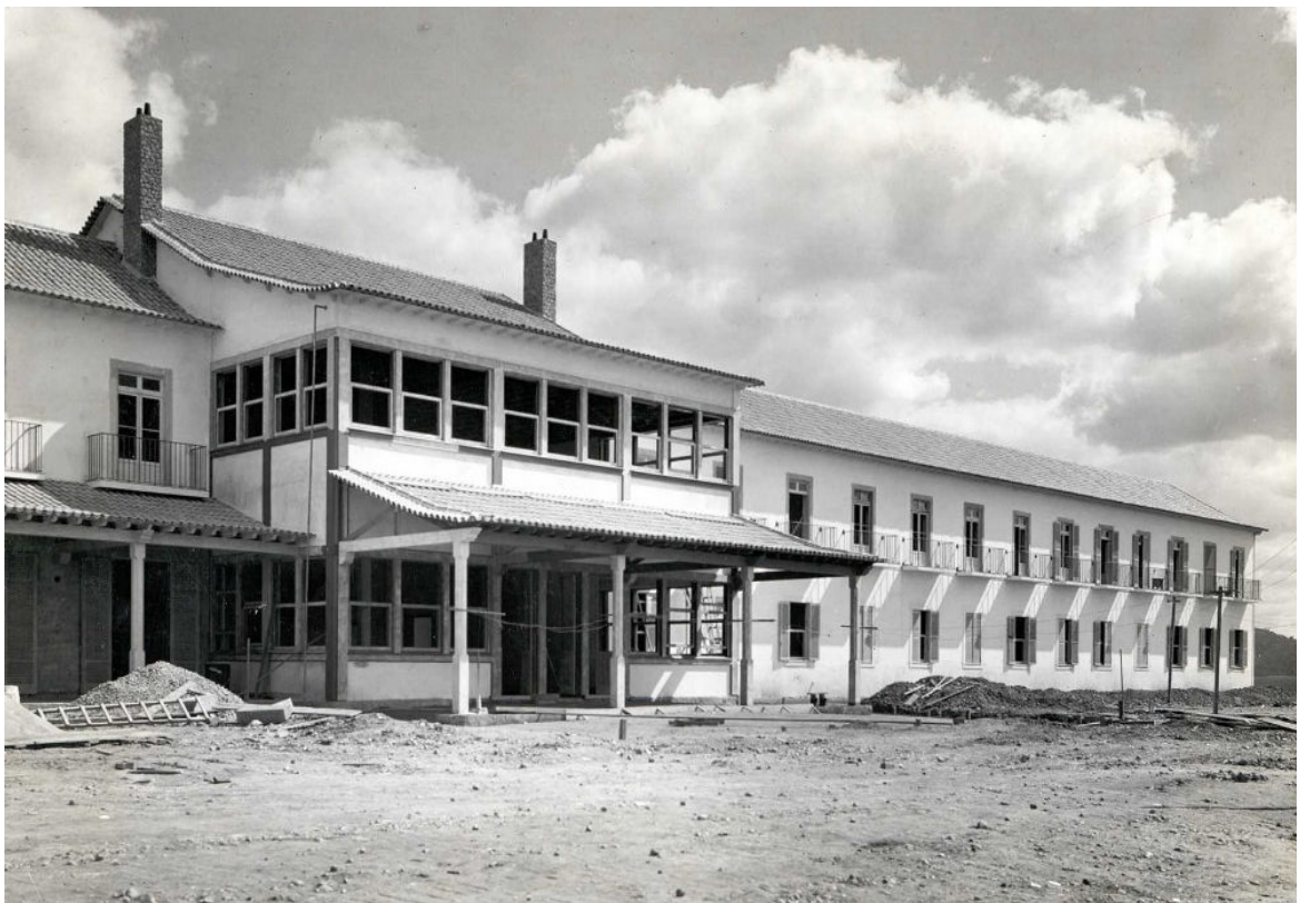
Figura 17 – Finalização da obra.
