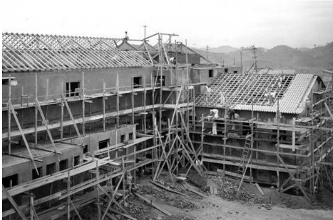
Figura 13 – Madeiramento do telhado.
