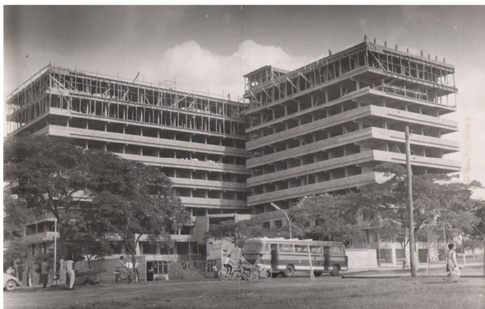
Figura 12 - Edifício GACEMSS - Em construção 1962.
