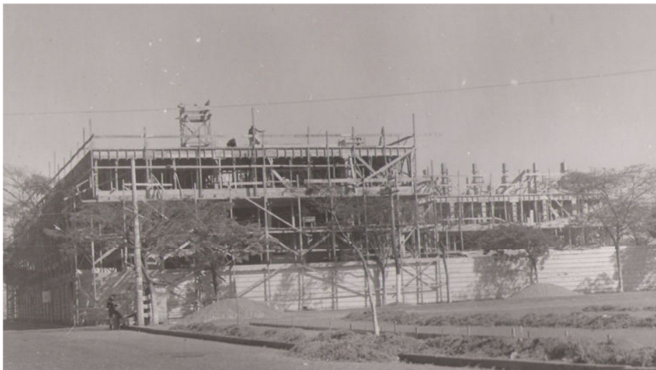
Figura 11- Edifício GACEMSS - Em construção 1961.
