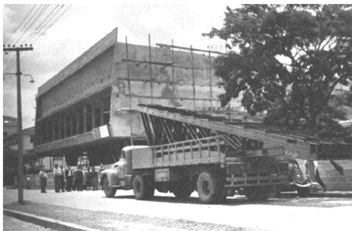
Figura 23 – Fase de acabamento, 1959.
