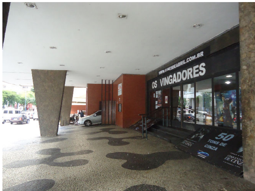
Figura 11 – Calçada da Fachada Principal.
