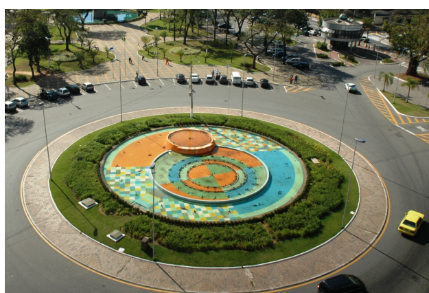
Foto 22: Detalhe da Fonte original
