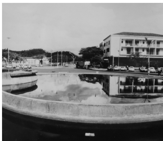
Foto 20: Detalhe da Fonte original
