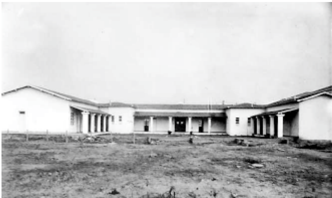
Figura 6 - Pátio interno, na época da construção.
