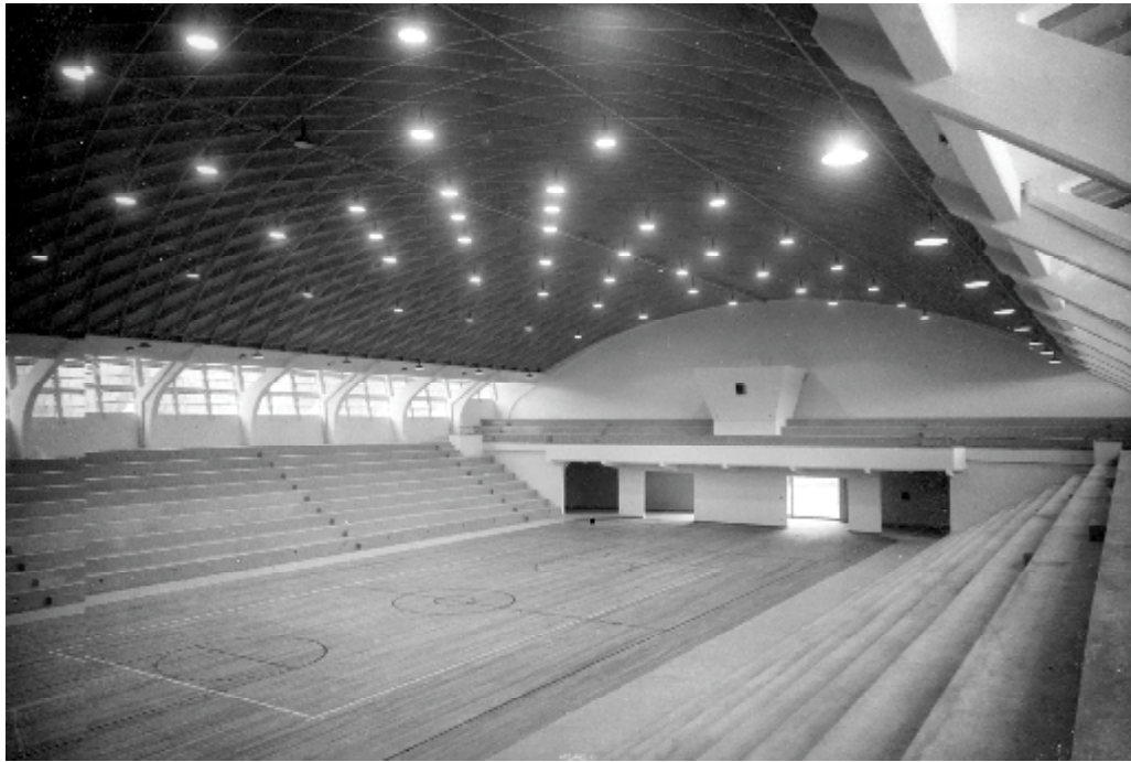
Figura 6 - Vista do interior demonstrando o quão ventilado e arejado é a construção.
