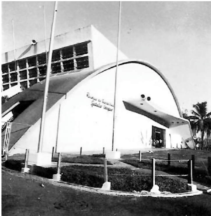
Figura 8 - Marquise na fachada principal, com o letreiro.
