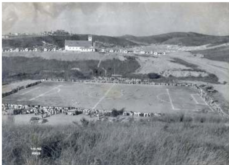
Figura 14 - Área do campo antes da construção do Conjunto Desportivo.
