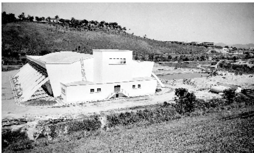
Figura 5 - Construção no formato "Trapézio Invertido" explosão de criatividade.
