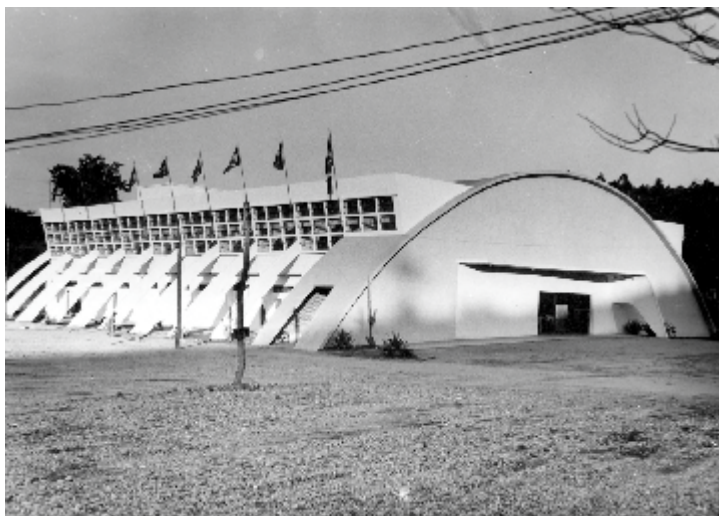
Figura 9 - Fachadas principal e lateral direita.
