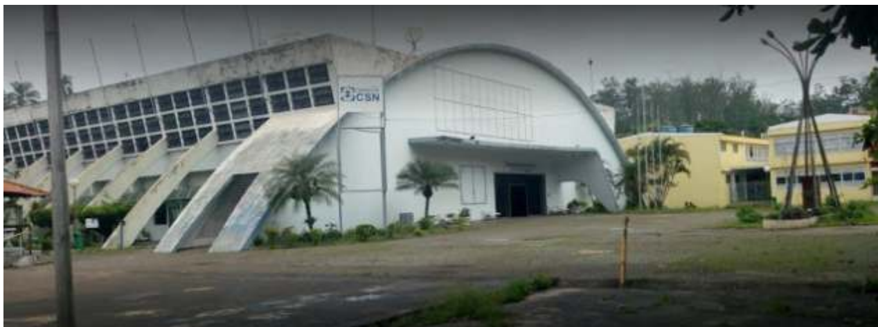
Figura 20 - Fachada nos dias atuais.
