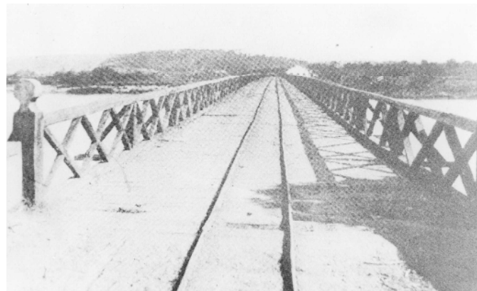
Fig. 13 - Ponte de madeira ligando Niterói à margem direita
