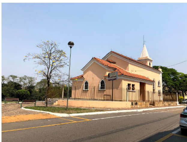
Figura 7 - Fachada Lateral e de Fundos com acesso para o jardim.
