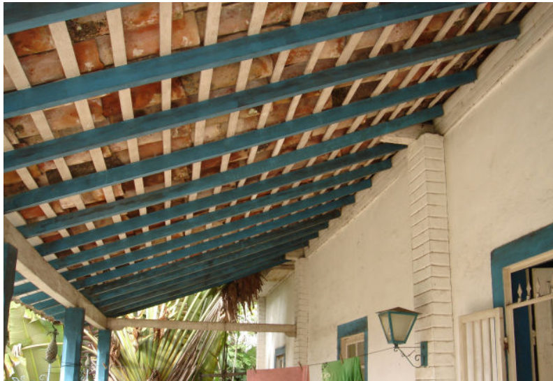
Figura 4- Detalhe do Telhado.
