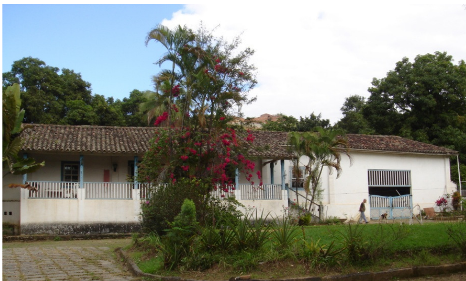
Figura 1- Vista da Casa Sede da Fazenda São João Batista.
