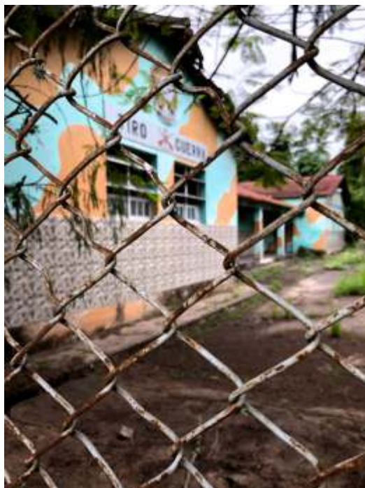
Figura 10 - Lateral através da cerca de proteção.
