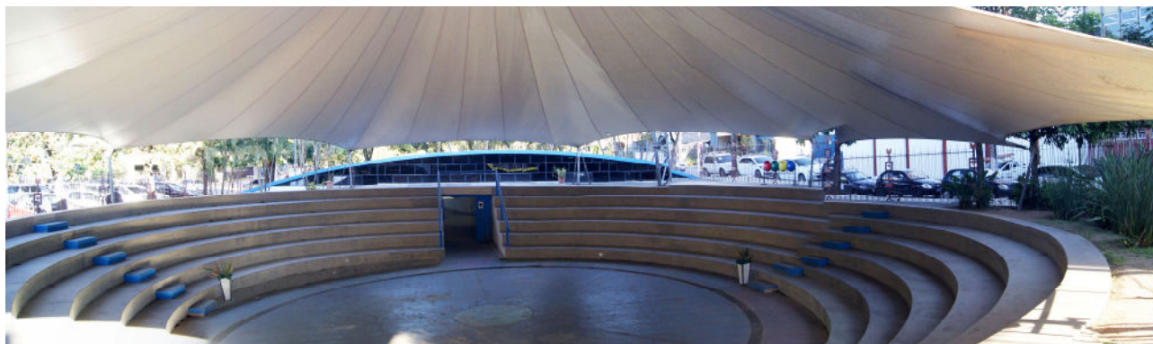
Figura 11 - Vista interna da Arena já com as intervenções.
