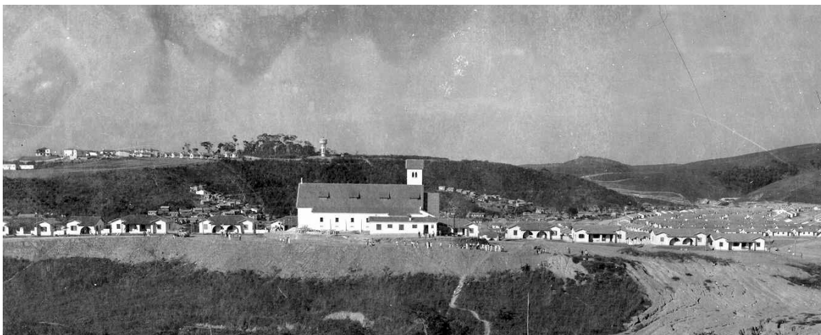
Figura 9- Fachada Lateral direita e as residências no entorno.
